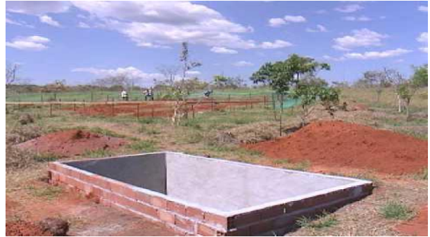
Ilustração 2: Tanque escavado e paredes construídas impermeabilizadas.
